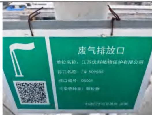
粉体车间废气排口标识牌 (FQ-509505)
