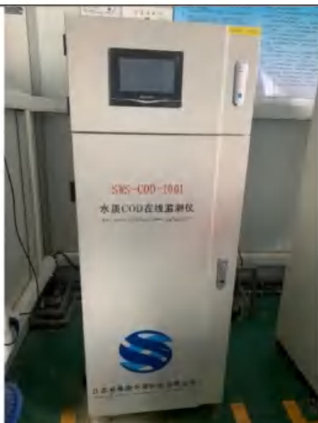
废水总排口 COD 在线监测仪
