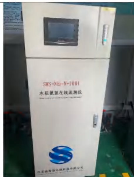
废水总排口氨氮在线监测仪
